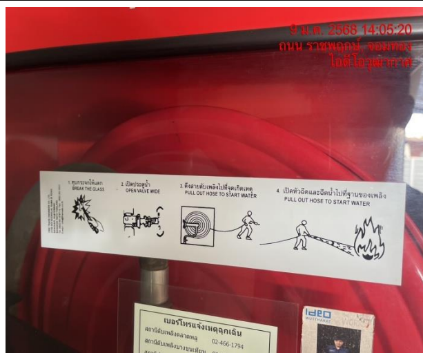
ภาพที่ 23 ป้ายแนะนำการใช้อุปกรณ์ดับเพลิงต่างๆ
